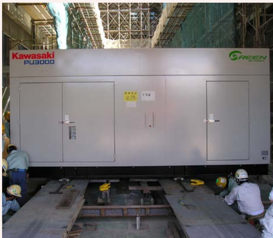
自家発電装置
