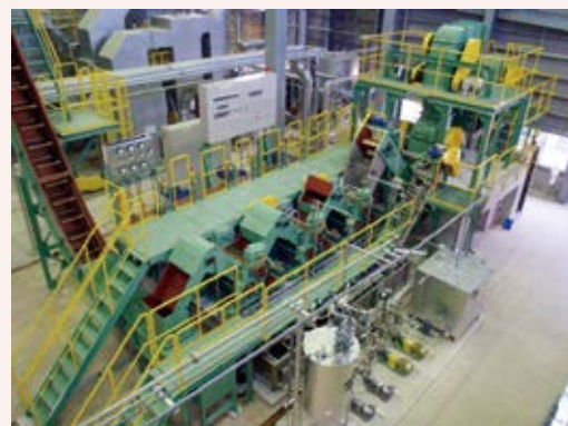
製糖工場設備(圧搾設備)
