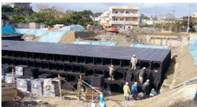
土木工事・雨水貯水槽
