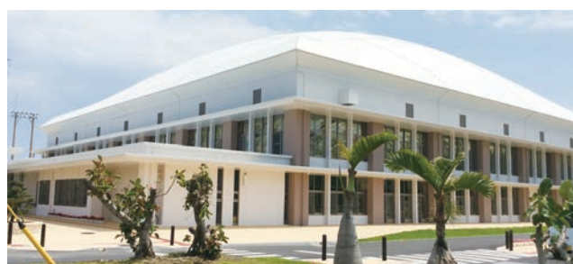
宜野湾市屋外運動場建築工事（膜屋根工事）
