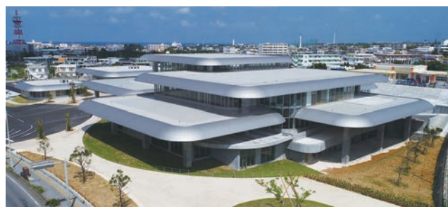
宮古未来創造センター（建築）
